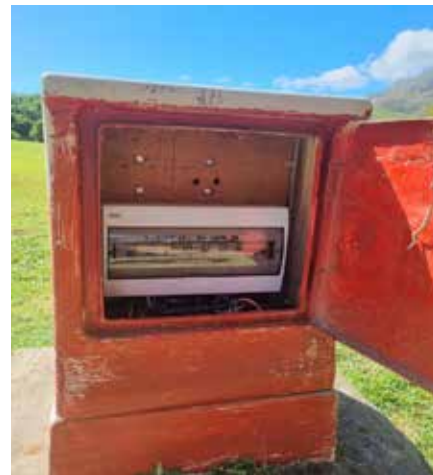
Vervanging van die distribusiebord by die slaapkwartiere op die perseel van Okkie Jooste kultuurfasiliteit in Jonkershoek, Stellenbosch.
