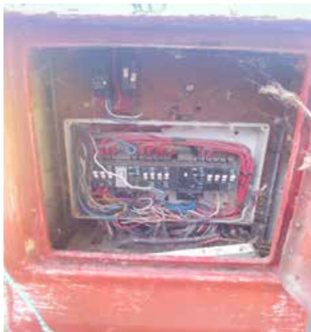
Vervanging van die distribusiebord by die slaapkwartiere op die perseel van Okkie Jooste kultuurfasiliteit in Jonkershoek, Stellenbosch.
