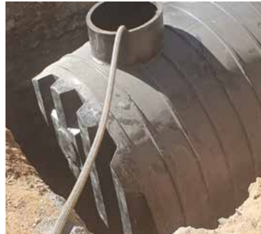
Opgraderings aan die rioolstelsel verbind aan die personeelbehuising op die perseel van Schoemanspoort kultuurfasiliteit in Oudtshoorn.
